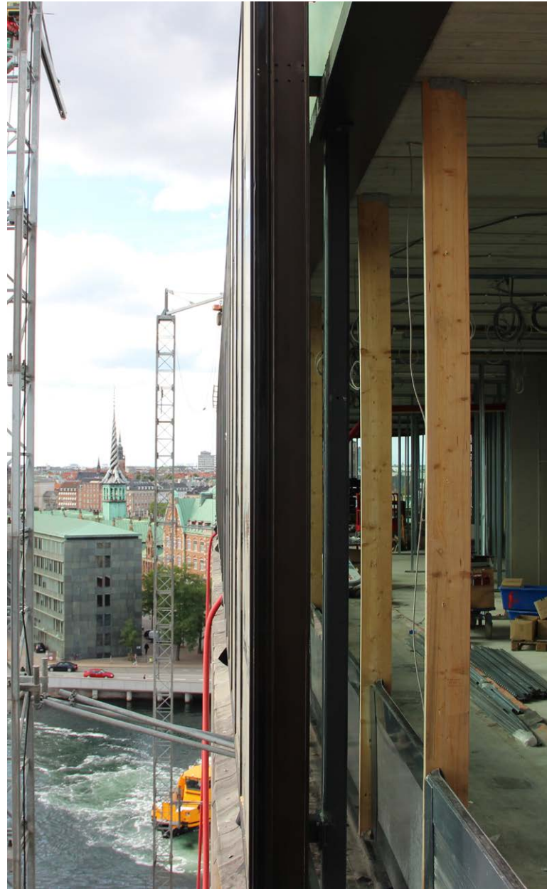
Den bærende konstruktion bliver bevaret i facaden, men bygningen bliver efterisoleret.
